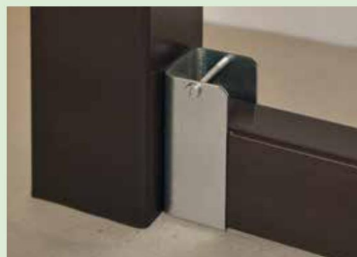
Detail úchytky s fixačním šroubem
