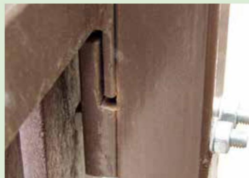
Detail úchytky s fixačním šroubem
